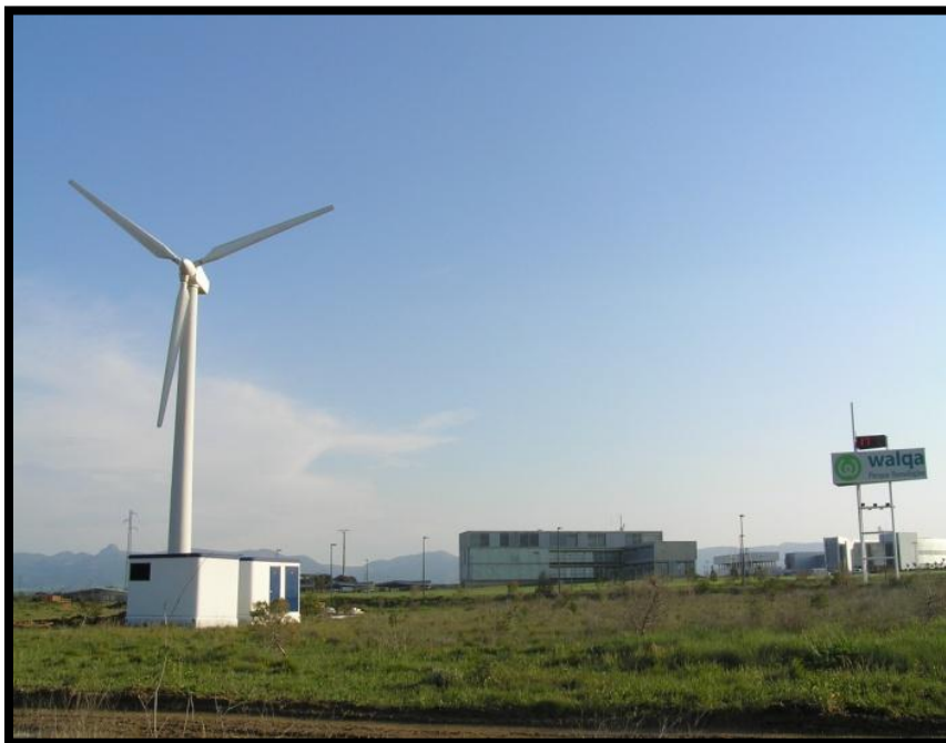
Proyecto IThER, "Infraestructura Tecnológica del Hidrógeno y Energías Renovables", Fuente: Fundación para el desarrollo de las Nuevas Tecnologías del Hidrógeno en Aragón.
